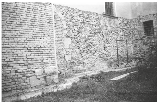
Obr. 17. Loštice, kostel sv. Prokopa. Celkový pohled na JV zeď presbytáře z roku 1993. Vlevo patrná dochovaná část románského bočního vstupního portálu, uprostřed mladší vyzdívka statické poruchy. Foto K. Faltýnek.
