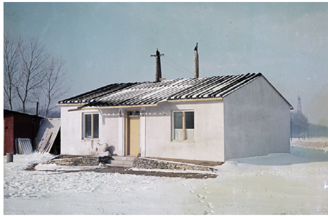
Obr. 6. Pôvodná budova bieleho domu postavená v roku 1955. Foto F. Šlapal. Fig. 6. The original building of the White House built in 1955. Photo by F. Šlapal.
