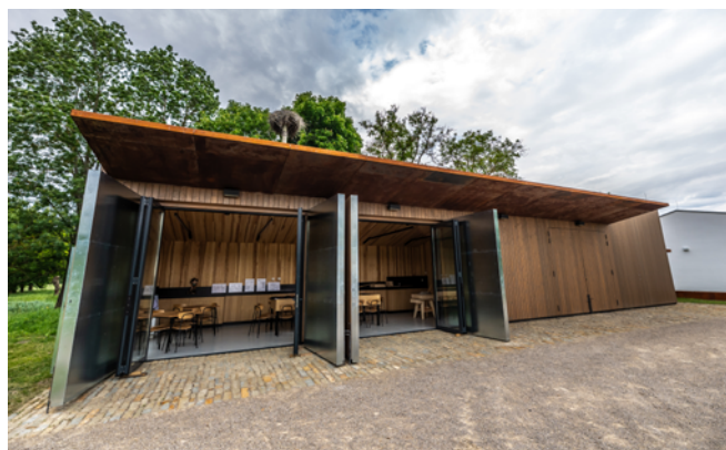
Obr. 5. Tzv. šopa, novovybudovaná polyfunkčná budova stojaca na mieste bývalej hospodárskej budovy. Foto J. Plavec, AV ČR. Fig. 5. The so-called Shed, a newly built multifunctional building standing on the site of a former farm building. Photo by J. Plavec, CAS.
