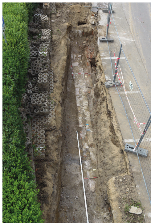
Obr. 26. Brno, Mendlovo náměstí, Fakultní nemocnice u sv. Anny. Vyzdění severního břehu Svrateckého náhonu v areálu Fakultní nemocnice u sv. Anny (sonda S7). Foto Archaia Brno z. ú.
