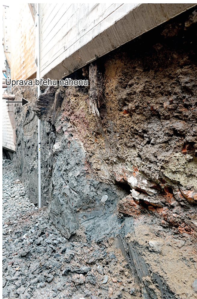
Obr. 29. Brno, Mendlovo náměstí. Středověká úprava severního břehu Svrateckého náhonu ve výkopu kanalizace. Foto Archaia Brno z. ú.
